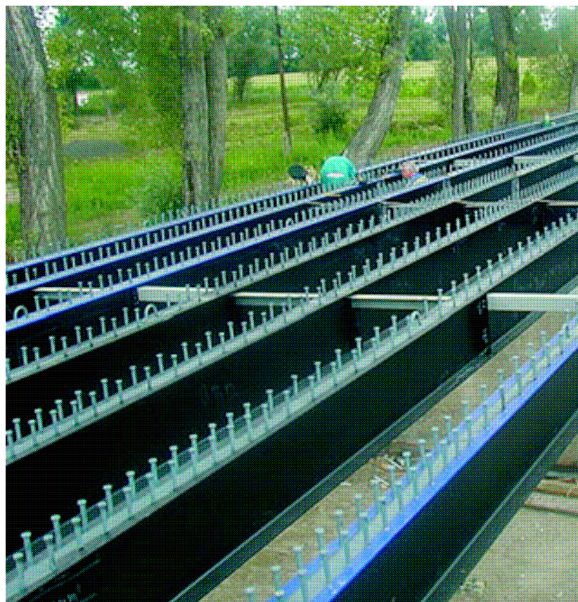
Obr. 10 Příklad použití přivařování svorníků ve stavebnictví
