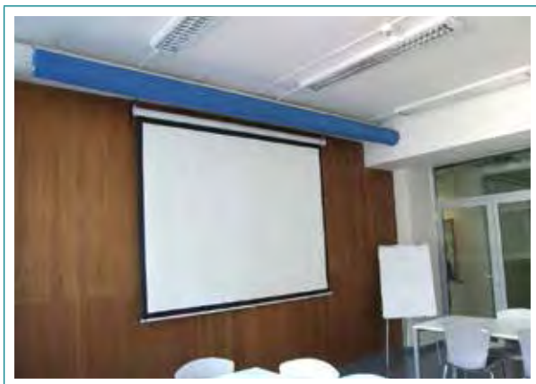
Obr. 6.8 Distribuce přiváděného vzduchu v učebně textilní vyústkou (foto: prof. Tywoniak)
