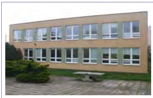
Obr. 2.7 Typické provedení okenních výplní v učebnách zrekonstruovaných škol (foto: archiv autora)
