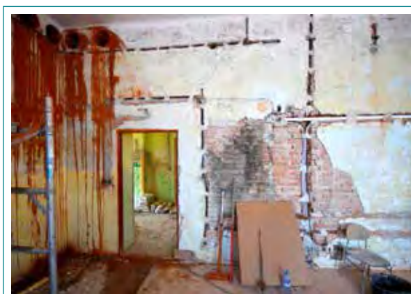
Obr. 6.4 Řešení přívodu a odvodu vzduchu v učebně (zdroj: Atrea)
