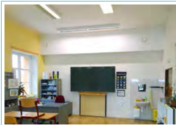
Obr. 6.2 Řešení přívodu a odvodu vzduchu v učebně (zdroj: Atrea)
