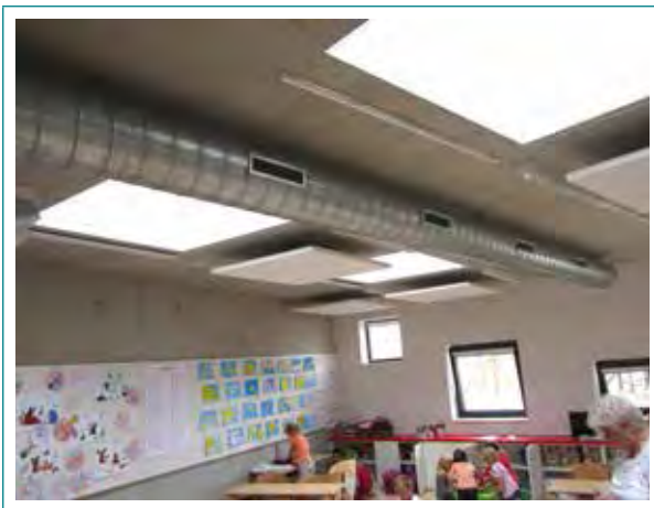
Obr. 6.10 Přívod vzduchu do učeben
