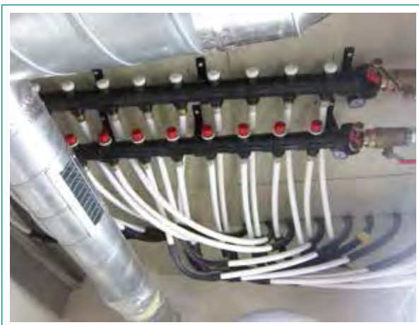
Obr. 6.12 Rozvody vzduchu, otopné a chladicí vody
