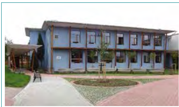
Obr. 6.18 ZŠ Slivenec (zdroj: ZŠ Slivenec, Atrea)
