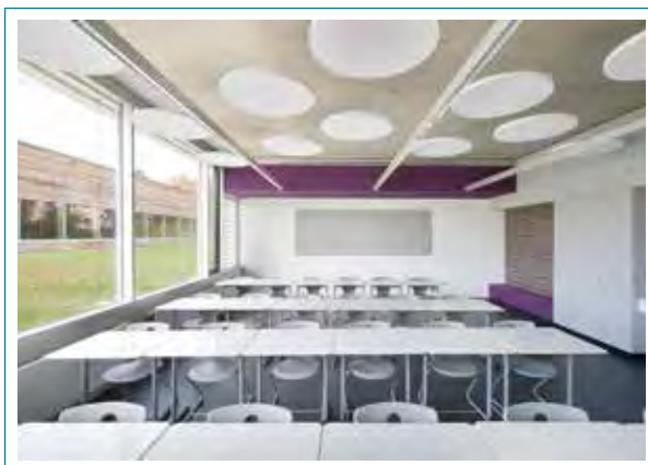
Obr. 6.15 Moderní učebna vybavená podstropní jednotkou (Philipp-Matthäus-Hahn-Gymnasium, Leinfelden-Echterdingen, zdroj: LTG Aktiengesellschaft)
