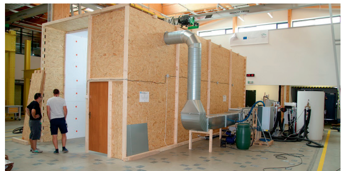
Obr. 5 Testovací komora napojená na vzduchotechnickou jednotku pro zajištění zkušebních klimatických podmínek
